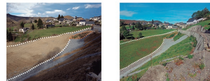
Figura 12: : l'abans i el després de la restauració ecològica mitjançant revegetització amb espècies locals d'un talús afectat per esllavissaments de terra fent servir l'enfocament ECOVARS, a Gasòst, Migdia-Pirineu. Font: CBNPMP
