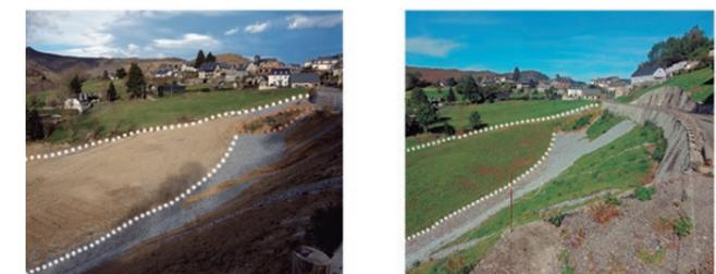
Figura 12: el antes y el después de la restauración ecológica mediante revegetalización con especies locales de un talud afectado por deslizamientos de tierra empleando el enfoque ECOVARS, en Gazost, Mediodía-Pirineos. Fuente: CBNPMP
