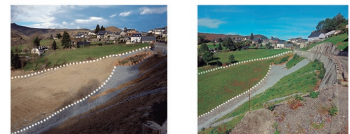
Figure 12: avant et après la restauration écologique par la revégétalisation avec des espèces locales d'un talus touché par des glissements de terrain en utilisant l'approche ECOVARS, à Gazost, en Occitanie. Source : CBNPMP
