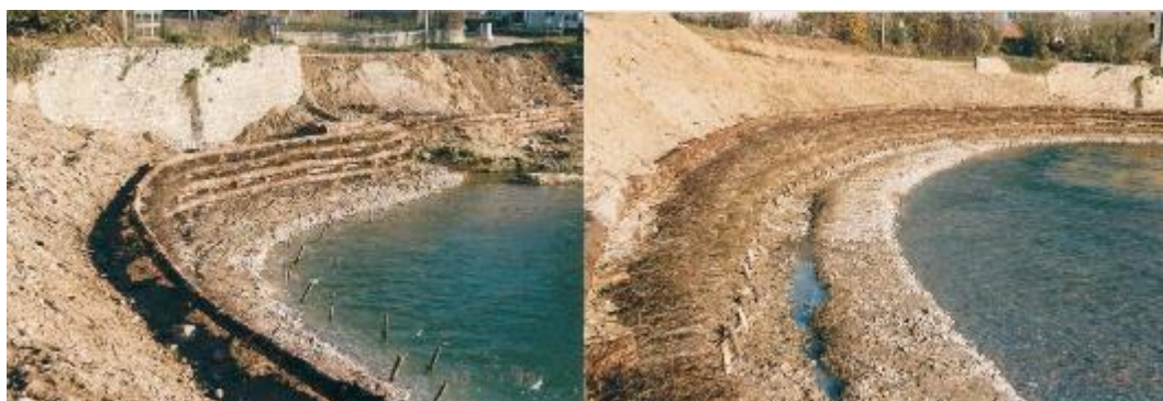
Figura 2-20. Ejemplo de estabilización de taludes fluviales en una zona urbana (Klaus Peklo, EFIB).
