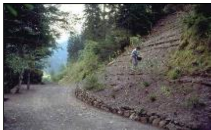
Figura 2-1. Técnica de recubrimiento: siembra al voleo en estructura. Florin Florineth (EFIB, Paola Sangalli).
