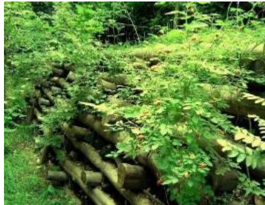
Figura 2-12. Técnica mixta. Foto de entramado de madera una vez vegetado (EFIB, Paola Sangalli).
