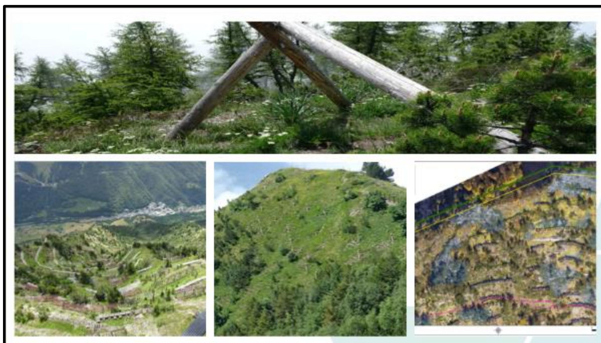
Figura 3-3. Ilustraciones del emplazamiento del bosque de Capet y de las NBS aplicadas por PHUSICOS (tripodes de madera y repoblación forestal). En la parte inferior izquierda de la figura se pueden ver infraestructuras grises en la ladera con el pueblo de Barèges al fondo.
