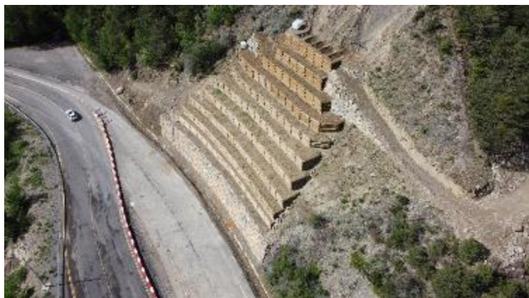
Figura 1-7. Vista general en el emplazamiento de Santa Elena, tomada con dron, con el muro de mampostería y las terrazas de madera al final de las obras.
