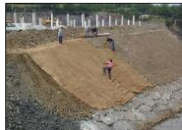
Figura 2-3. Técnica de recubrimiento: colocación de manta orgánica. Valentín Contreras (EFIB, Paola Sangalli).
