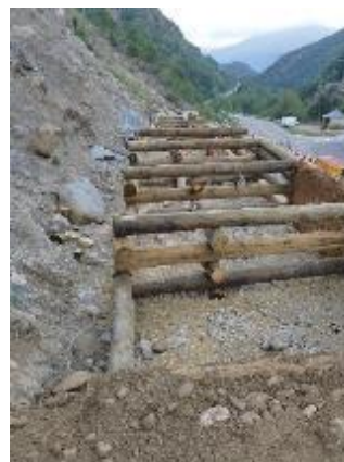
Figura 1-8. Detalle de los gaviones de madera durante la construcción.
