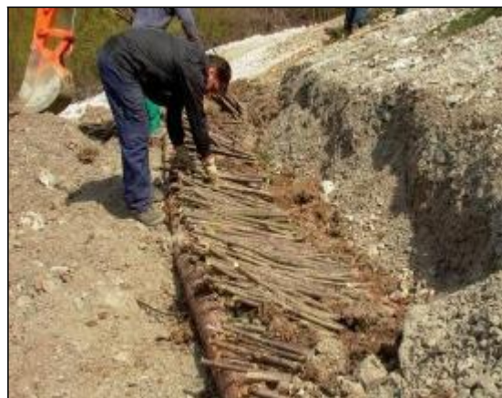
Figura 2-7. Técnica de estabilización. Foto de los peldaños de madera. (EFIB, Paola Sangalli).
