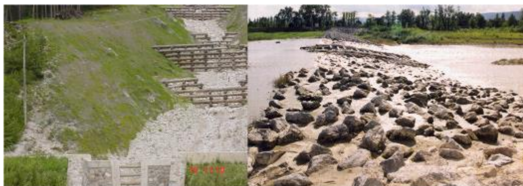
Figura 2-18. Técnica complementaria. Presas de torrente y rampa de piedra para peces (EFIB, Paola Sangalli).
