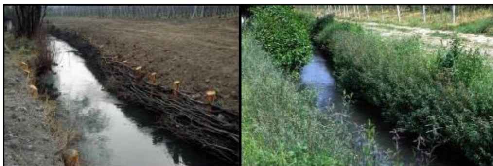
Figura 2-8. Técnica de estabilización. Fotos de trenzas de mimbre de Florin Florineth (EFIB, Paola Sangalli).
