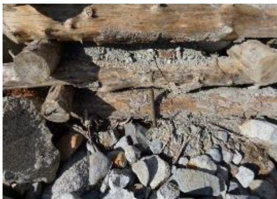
Figura 1-10. Detalle del muro krainer relleno de material.
