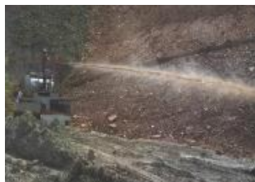
Figura 2-2. Técnica de recubrimiento: hidrosiembra (EFIB, Paola Sangalli).
