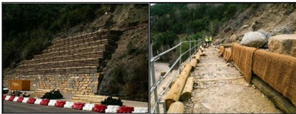
Figura 3-9. Zona de trabajo en el corte de Santa Elena. La zona de control incluye diez terrazas de 2 m de ancho y longitud decreciente (desde 30 m para el nivel más bajo hasta unos 10 m para el nivel superior).
