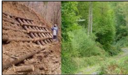
Figura 2-14. Técnica mixta. Espaldera en Leizaran y a la derecha después de un año (EFIB, Paola Sangalli).
