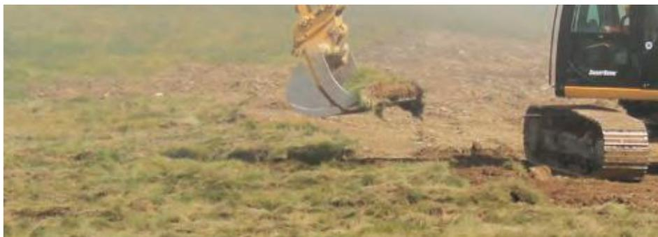
**Fig. 22 – Dépôt de plaques de pelouse à Gispet**
