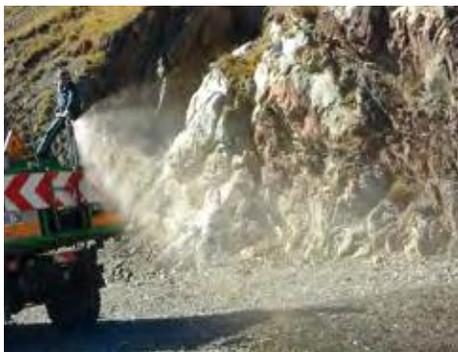
**Fig. 68a** – Semis à 125 kg/ha d'un mélange de semences locales récoltées à la brosseuse [Superbagnères, 06/10/17]. L'objectif était d'évaluer les performances des semences locales sur des substrats dégradés par d'anciens terrassements.
