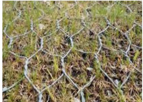
Fig. 62 – Fixation d'un semis avec un filet en toile de coco et un grillage. Le filet fixe le sol et les graines. Il offre de meilleures conditions de croissance aux plantules.
