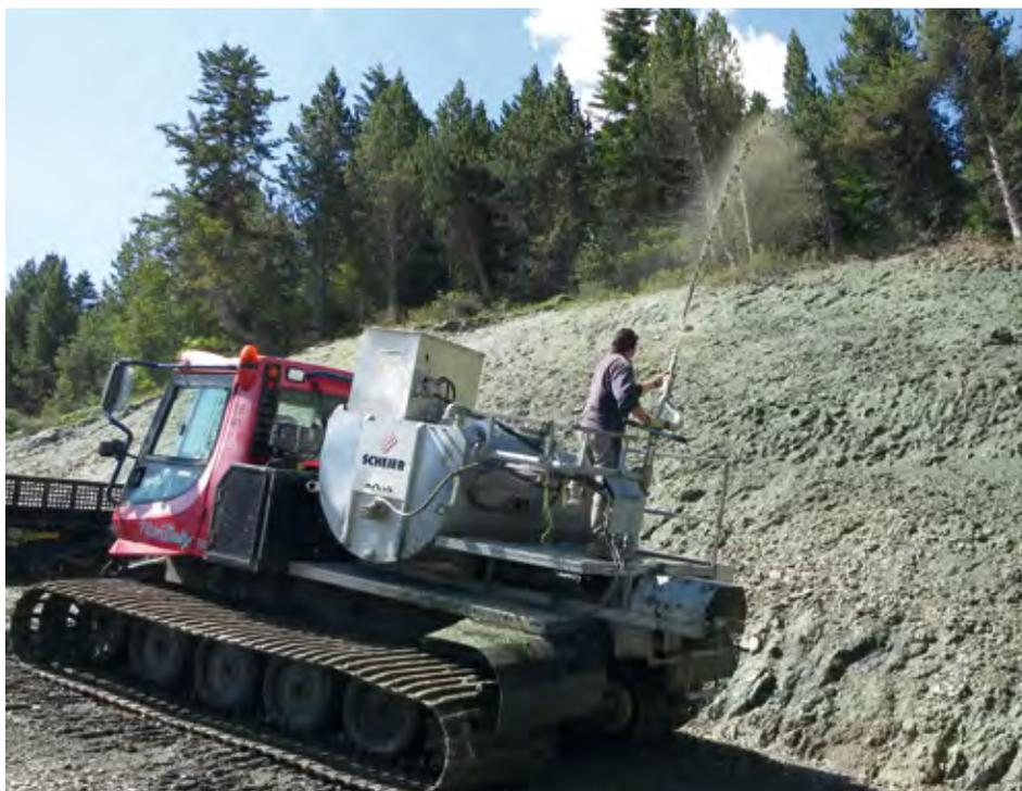
Fig. 66 – Semis à l'hydroseeder
