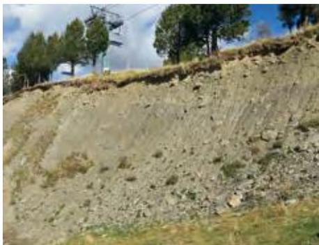
Fig. 72a – Talus avant restauration écologique avec 100 kg/ha de semences récoltées à la brosseuse et du mulch à fibres de bois longues (Andorre, Soldeu el Tarter, 07/10/15).
