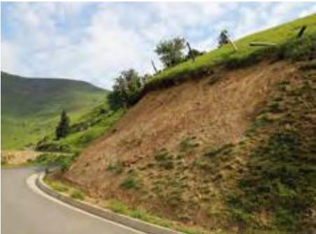
Fig. 61 – Effet de l'utilisation d'un filet sur l'implantation d'un semis. Sur la partie droite du talus, la pose d'un filet en toile de jute a favorisé le développement et la fixation des plantes semées.
