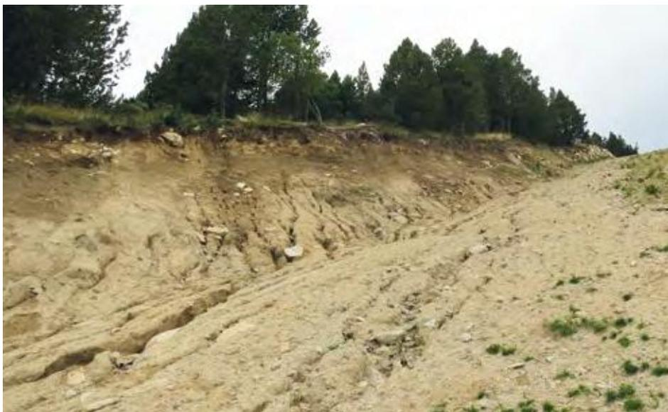
**Fig. 15 – Talus et piste de ski très dégradés par l'érosion hydrique**
