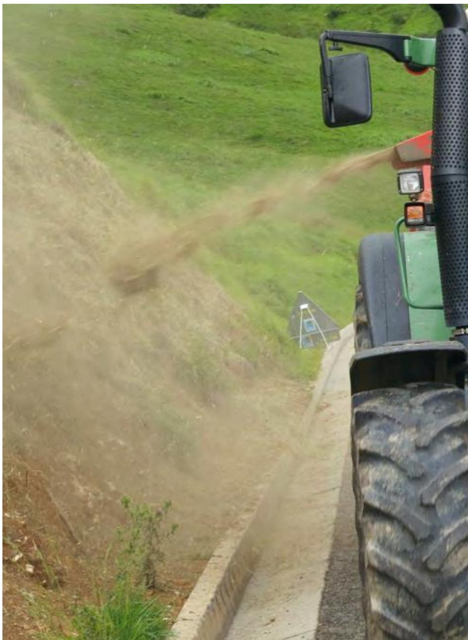
Fig. 64 – Pailleuse utilisée pour ensemercer un talus routier avec du foin vert
